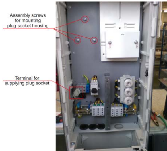
Kuva 6.1 Mittauskeskuksen sisäinen järjestely
