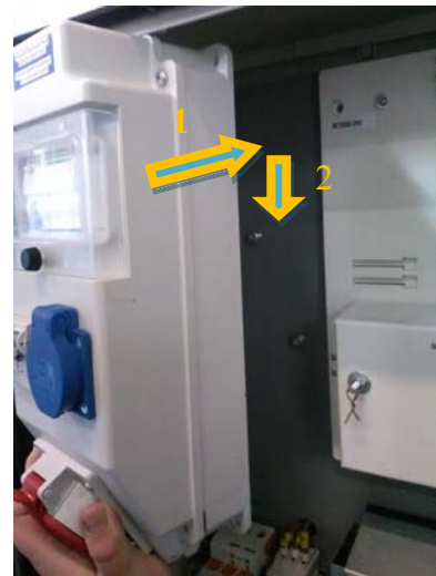
2. Ripusta pistorasian kotelo kiinnitysruuveihin
